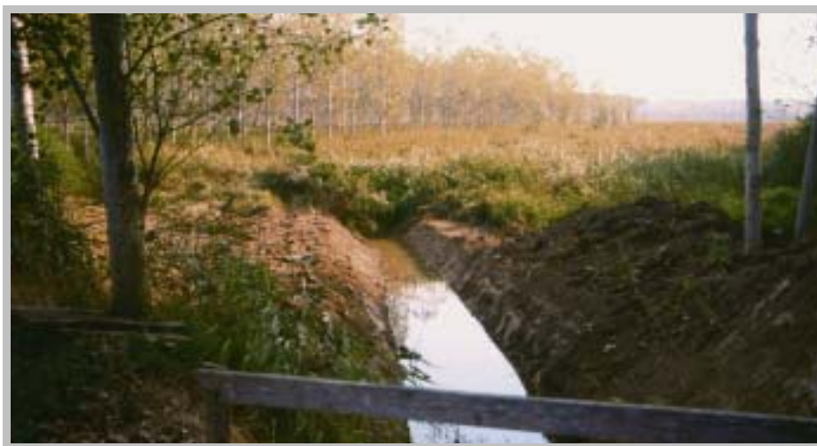
Fig. 2 - La realizzazione o il ripristino del reticolo idraulico di una zona umida rappresenta uno dei fondamentali interventi strutturali per l'incremento e la conservazione delle caratteristiche funzionali della stessa. Anche nel caso di zone umide preesistenti, spesso, si rende necessaria la realizzazione di nuovi canali o il recupero di quelli esistenti per valorizzare, dal punto di vista naturalistico, aree che altrimenti sarebbero destinate a degrado. Nella foto, il ripristino di un canale minore nel Padule di Fucecchio (foto F. Sorbetti Guerri).
