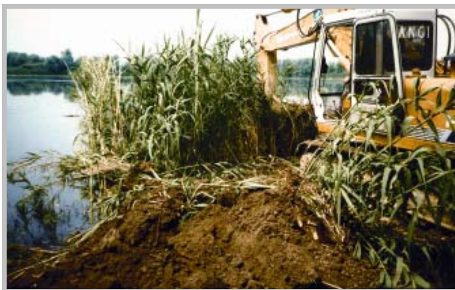
Fig. 12 - L'uso di macchine per movimento terra, anche se non ovunque utilizzabili nelle zone umide, rende più rapide ed efficaci le operazioni di modellamento delle sponde e dei fondali negli interventi di ripristino e realizzazione di zone umide. Ma l'impiego di tali macchinari risulta di notevole utilità anche nelle operazioni di manutenzione, particolarmente quando si debbano eseguire operazioni di rivitalizzazione di aree umide che abbiano perso le loro caratteristiche funzionali a causa dell'eccessivo interrimento (foto L. Pini).
